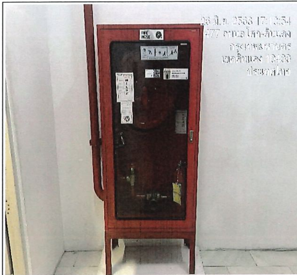
ภาพที่ 33 ตู้เก็บสายฉีดน้ำดับเพลิงพร้อมอุปกรณ์
