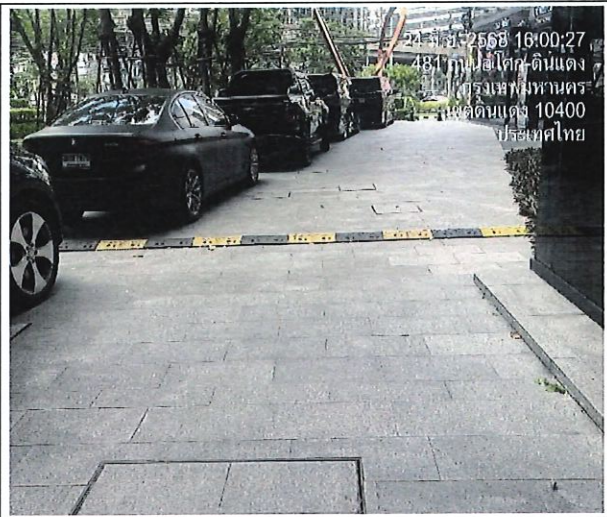
ภาพที่ 6 ติดตั้งสัญญาณชะลอความเร็ว จำนวน 3 จุด
