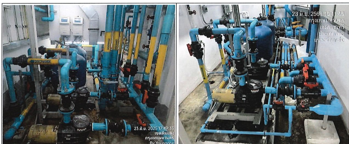
ภาพที่ 18 ระบบกรองน้ำสระว่ายน้ำ
